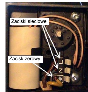
Rys. Podłączenie przewodów do pompy C.O.
